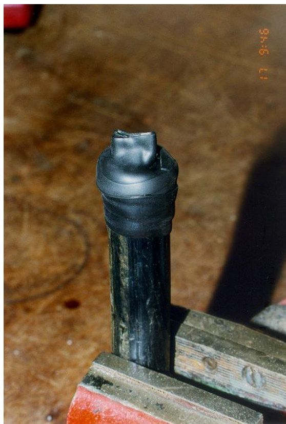
Po zamáčknutí je konec utěsněný.
