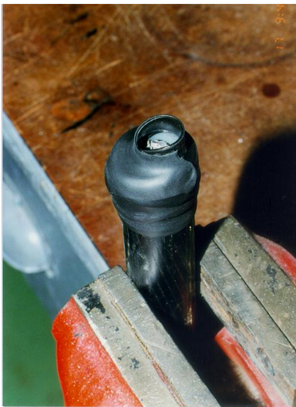
Páska 2228 navinutá na konec kabelu AXEKCEY
